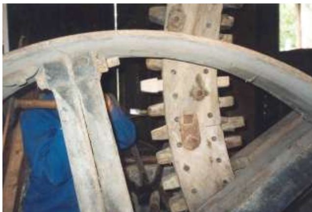
Abbildung 8 Einschlagen des Zahnes von der Seite aus gesehen
